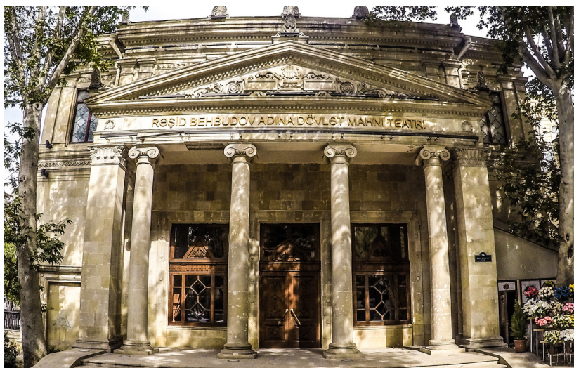
Нынешний облик исторического здания (Фото: Sefer azeri, Wikimedia Commons)
